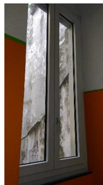
Figura 4.4 - Particolare dei serramenti
