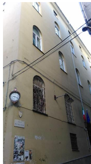
Figura 1.1 - Vista della facciata esposta a Sud
